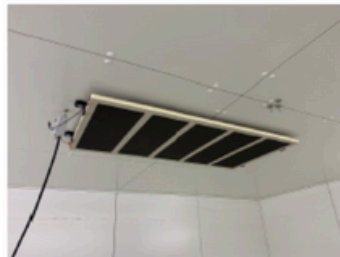
Abbildung 2: Montage des Heizgerätes an der Decke
